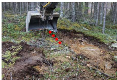
Рисунок 11. Снятие пласта дерна начинается с боковой канавы.
