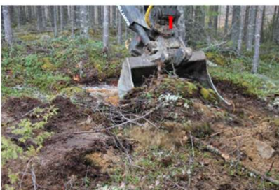
Рисунок 12. Срез пласта дерна с поверхности с помощью ковша.
