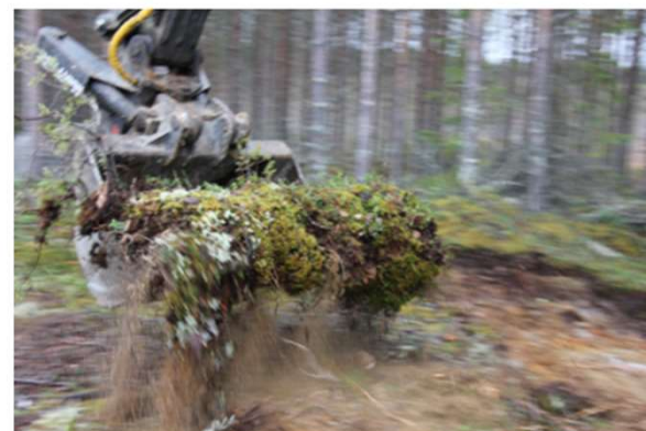
Рисунок 13. Перемещение снятого пласта дерна к каркасу дороги.
